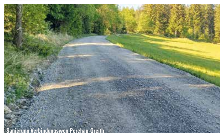
Sanierung Verbindungsweg Perchau-Greith
