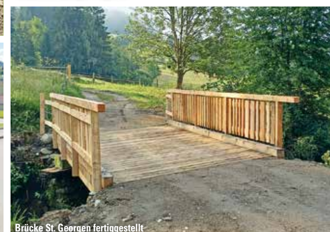
Brücke St. Georgen fertiggestellt
