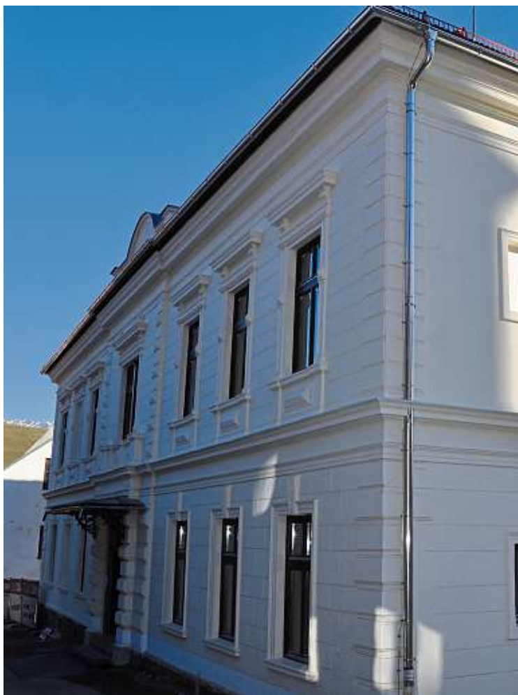
Alte Volksschule wurde im ersten Bauabschnitt saniert
