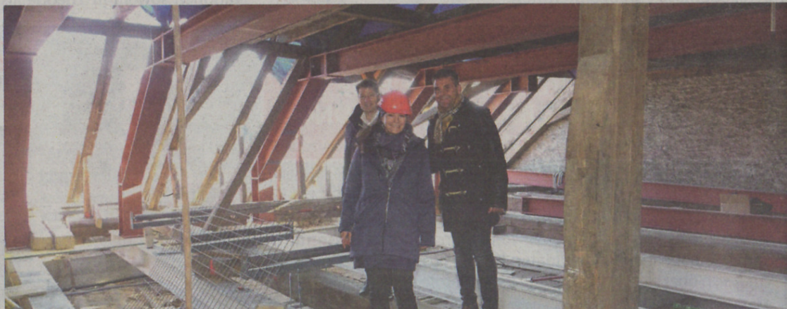
Auch das Dachgeschoss nimmt langsam Gestalt an. Bürgermeister Josef Maier mit seinem Vize Klaus Straner und Baumeisterin Ing. Elisabeth Löcker.
