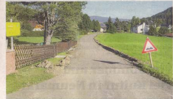
Der Zustand der Straßen und Wege wird neben den Instandhaltungen mit Asphaltierungen verbessert.
